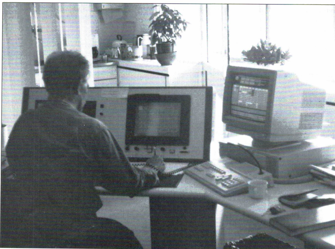
Bedienplaats twee van de CPA-Utrecht. Links het beeldscherm en de bedienterminal voor het mobilifoonsysteem. Het scherm voor de centralist is een 'touch screen' waarmee de telefooncentrale wordt bediend. De centralist hoeft hierbij alleen maar de gewenste telefoonlijn op het scherm aan te tikken en de verbinding wordt automatisch tot stand gebracht.
